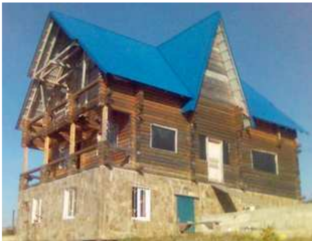
Так выглядел дом наблюдательной базы в начале строительства (январь 2007 года)
